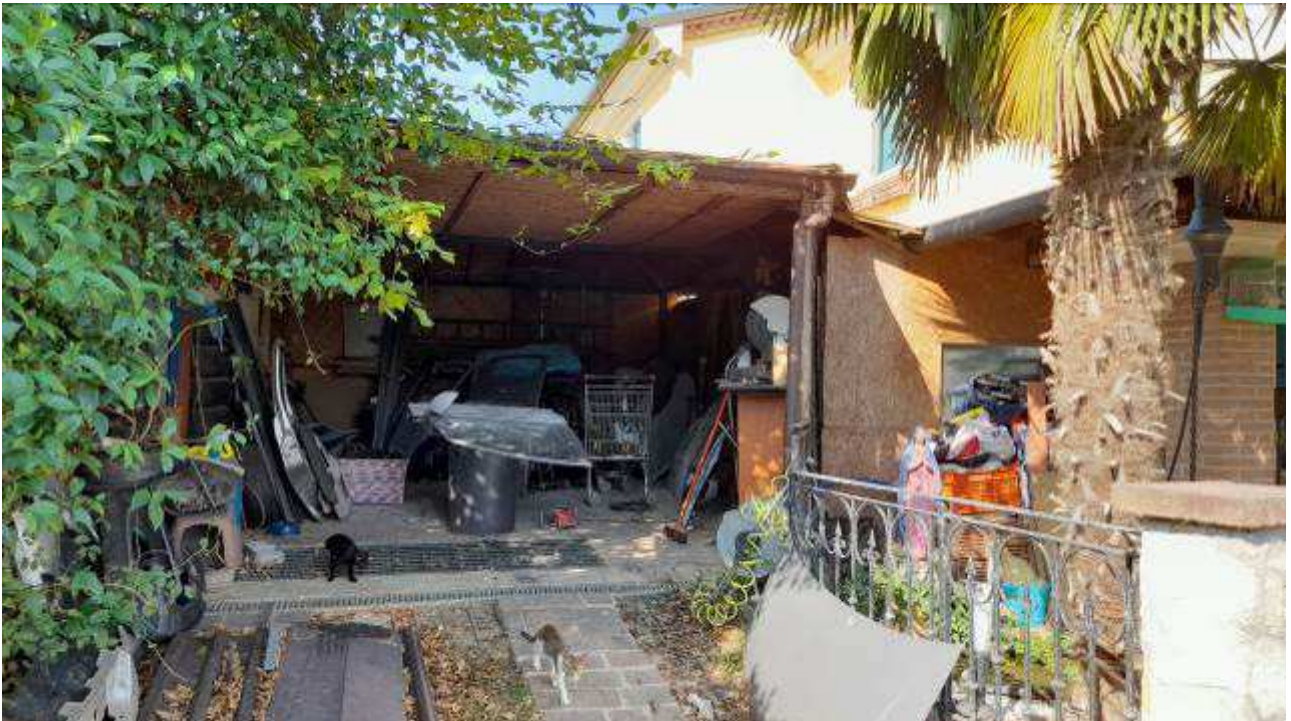
Figura 12. Manufatti non autorizzati, lato sud.
