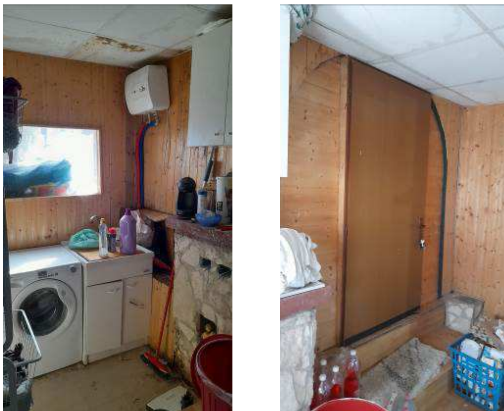
Figura 35. Vano non autorizzato al p.t. lato sud.
