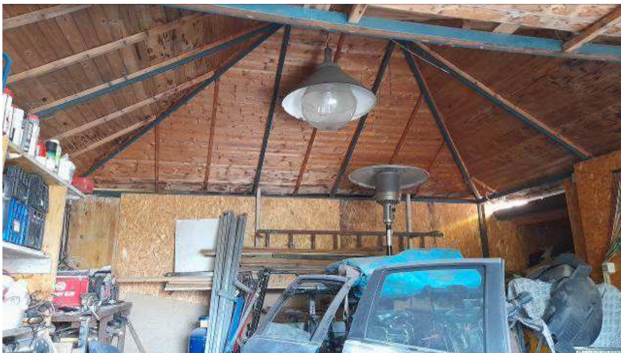
Figura 13. Manufatti non autorizzati, lato sud.
