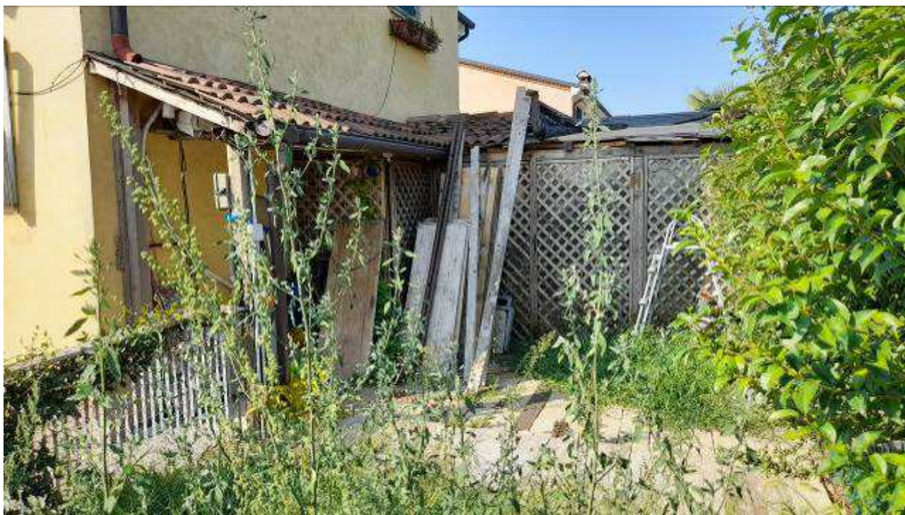
Figura 9. Vista area esterna nord e manufatti non autorizzati.
